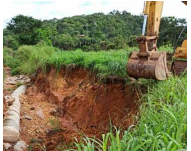
Equipes da Seinfra trabalham na recuperação da erosão na Rua VC-43
